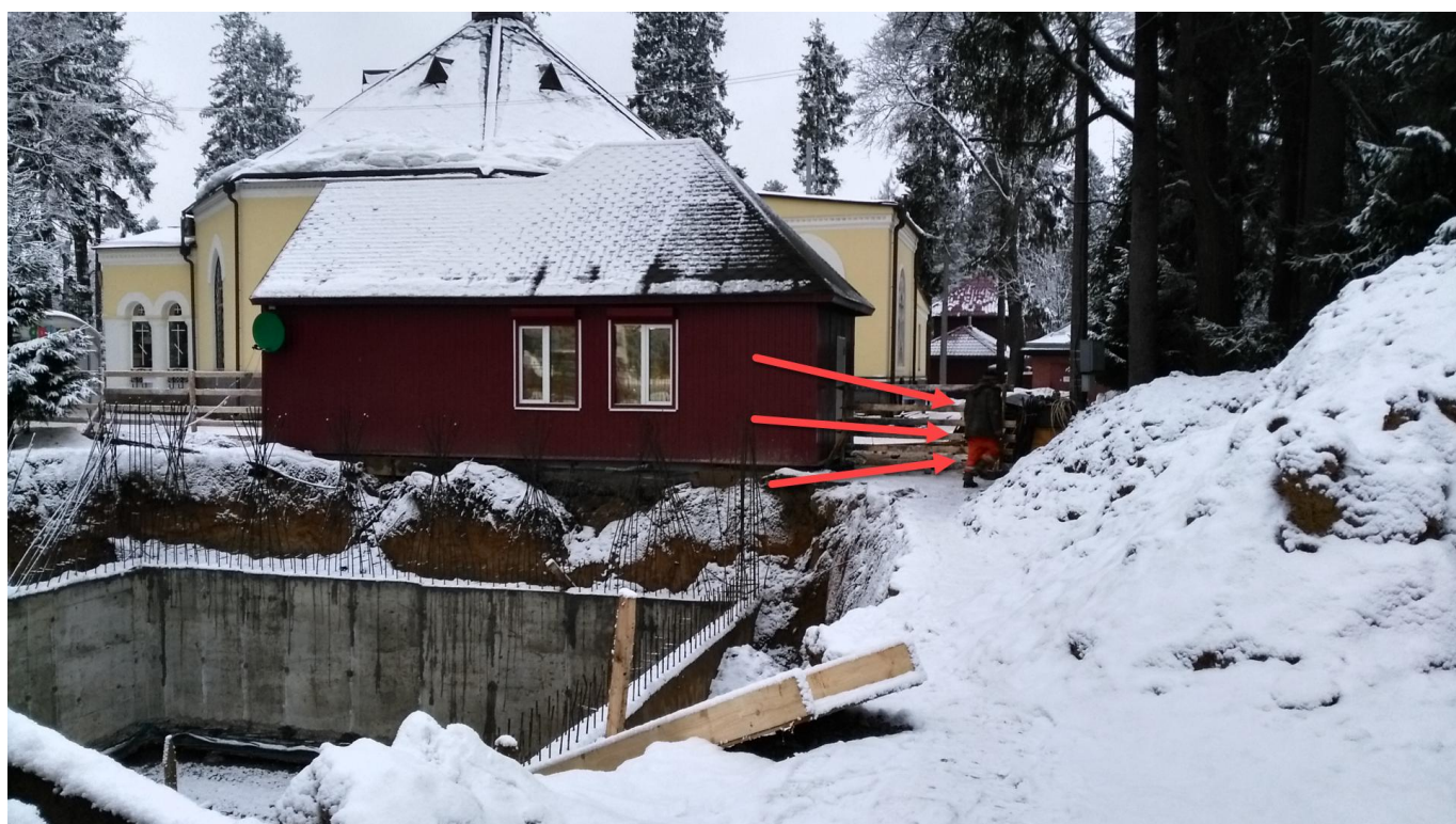
Фото от 16 декабря, суббота! Рабочие на стройке, работают без строительной техники.
